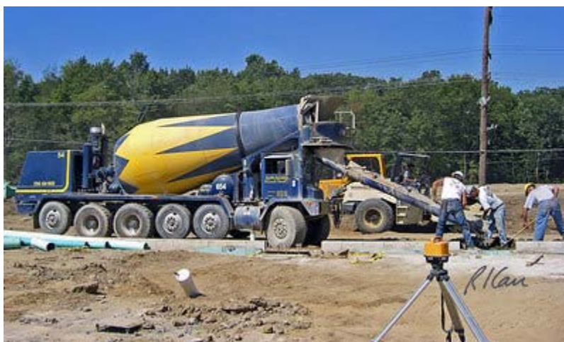
تراک میکسر تخلیه از جلو سوار بر کامیون ۱۰ چرخ
