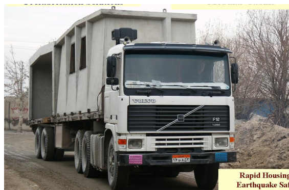
( قطعات سوله های پیش ساخته و طریقه حمل آنها )
