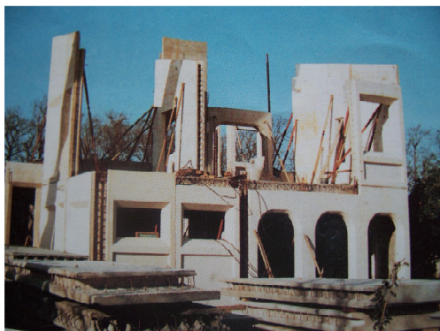
( مونتاز قطعات سیستم مدولار )
