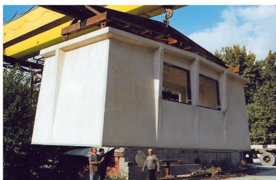
( قطعات سوله های پیش ساخته و طریقه حمل آنها )
