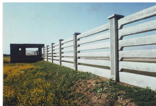
دیوار نما از چند قطعه بتنی
