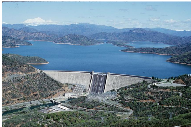
شکل ۸ : سد بتنی قوسی
