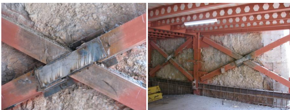
شکل ۱۹- نمایی از اتصال بادبند
