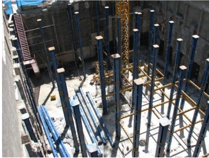
شکل ۱- نمایی از اجرای ستون های یک پروژه ساختمان فولادی میان مرتبه
