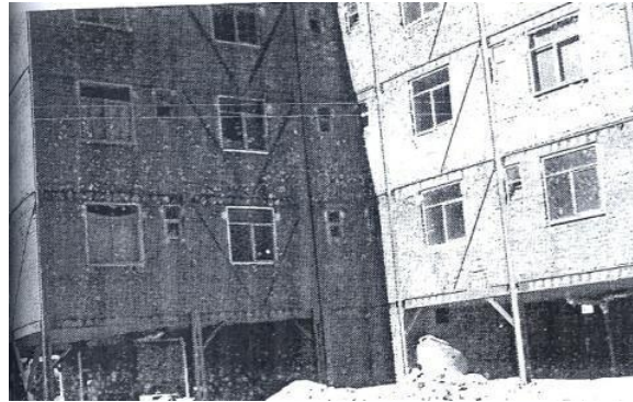
شکل ۱۶) دیوار ها و تیغه های پر کننده
