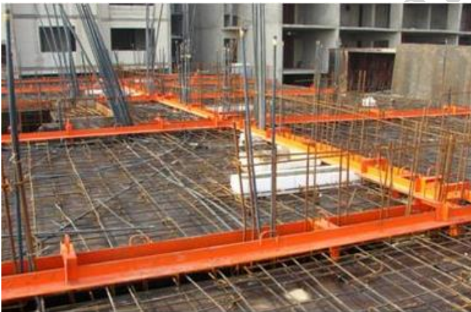
شکل (۳-۲۵) اجرای رامکا در قالب‌های تونلی
