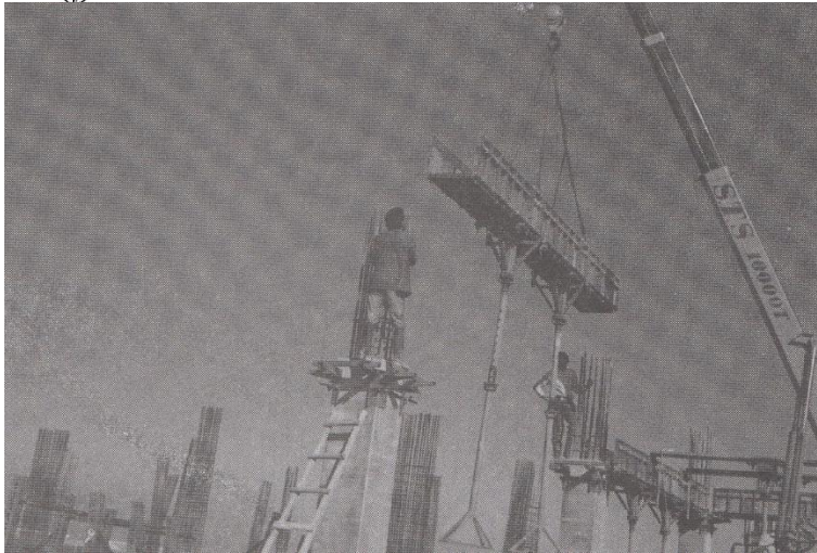
شکل (۳-۲۷) قالب یکپارچه تیر در حال پرواز
