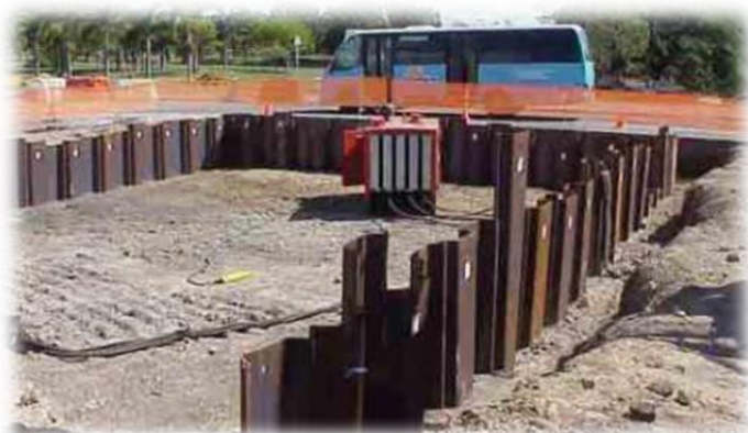
شکل (۸-۲) روش سپر کوبی
