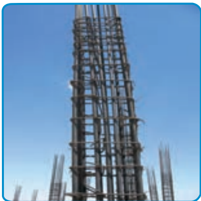
شکل ۱۹-۷- کار گذاشتن میلگردهای انتظار ستون، در فونداسیون
