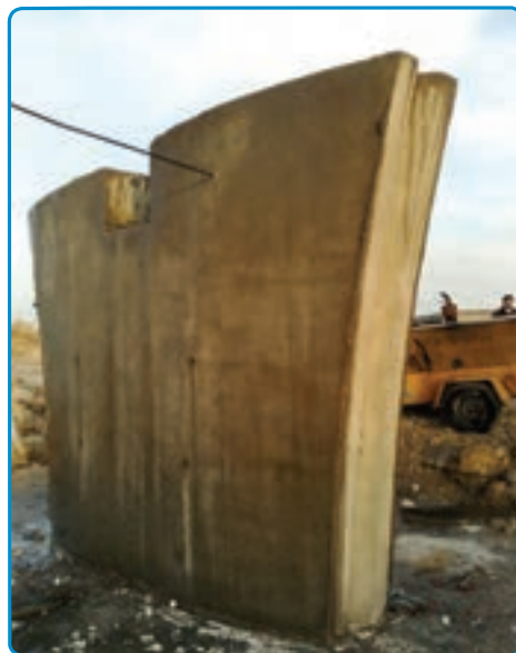
شکل ۳-۴۲- قالب برداری
