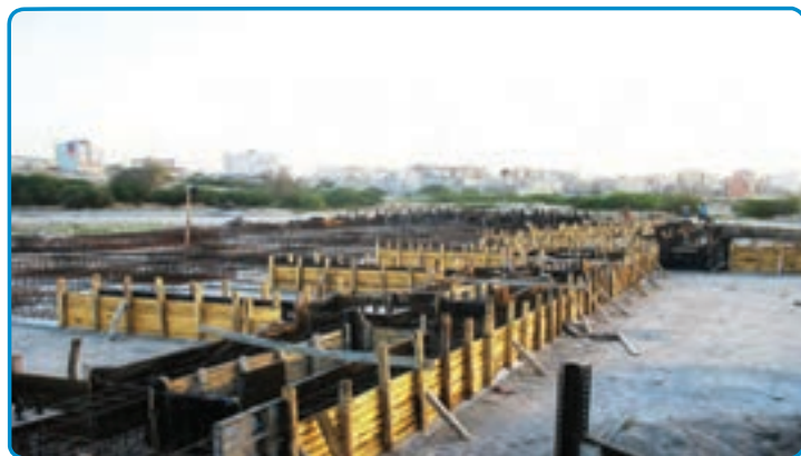
شکل ۳-۲۷- قالب چوبی برای اجرای پی
