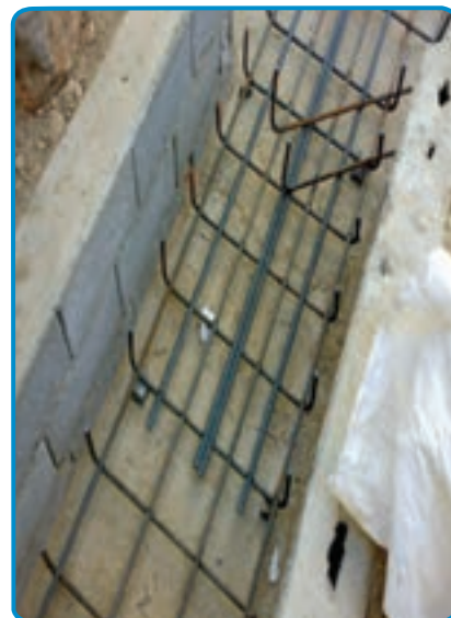
شکل ۱۱-۷- قرار دادن میلگردهای تقویتی
