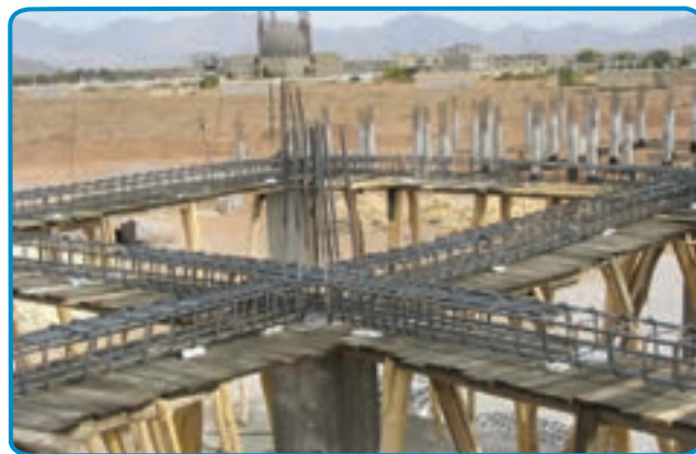
شکل ۷-۲۷- رعایت فاصله پوشش بتنی در کف
