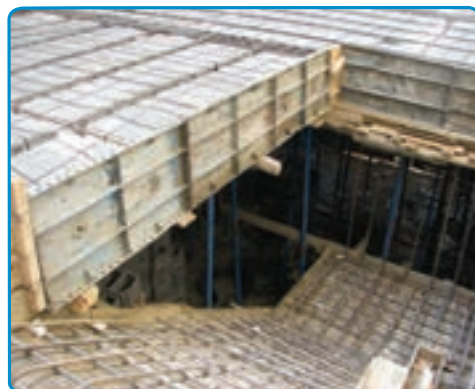
شکل ۴۰-۷- اجرای میلگردهای دال پله
