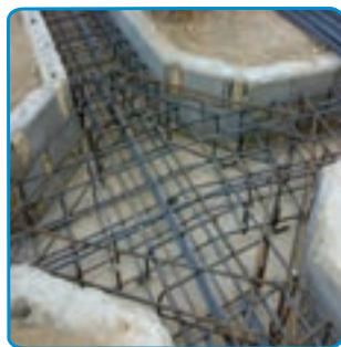
شکل ۱۴-۷- تکمیل میلگردگذاری محل اتصال ستون
