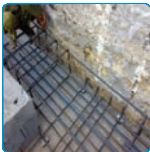
شکل ۱۲-۷- میلگردگذاری شبکه‌بالیایی
