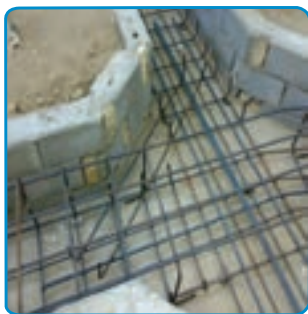
شکل ۱۳-۷- قرار دادن میلگردهای تقویتی پخ‌ها
