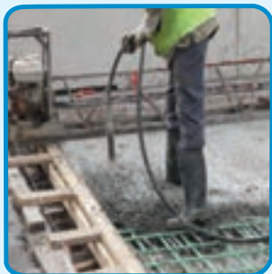
شکل ۱۴-۳- وایراتور یا لرزاننده بتن داخل قالب
