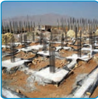
شکل ۱۷-۷- اجرای خاموت و سنجاقک
