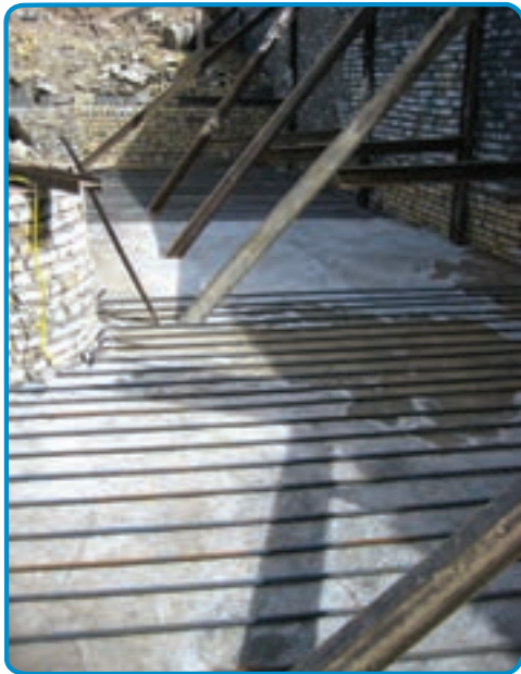
شکل ۳-۴۶- میلگرد طولی کف پی
