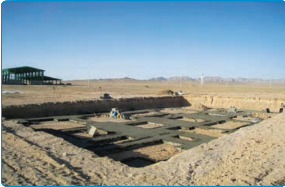
شکل ۳-۶- گودبرداری در زمین‌های نامحدود
