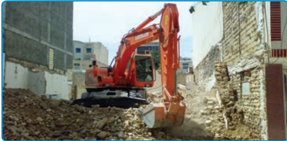
شکل ۳-۲- خاکبرداری با ماشین
