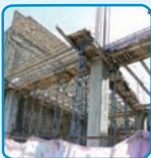
شکل ۳-۳۹- استفاده از قالب چوبی برای اجرای تیر
