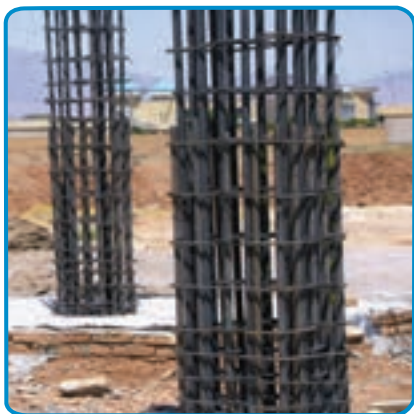
شکل ۱۶-۷- بتن ریزی ستون
