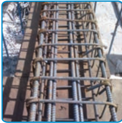
شکل ۷-۲۵- بستن خاموت ها با مفتول
