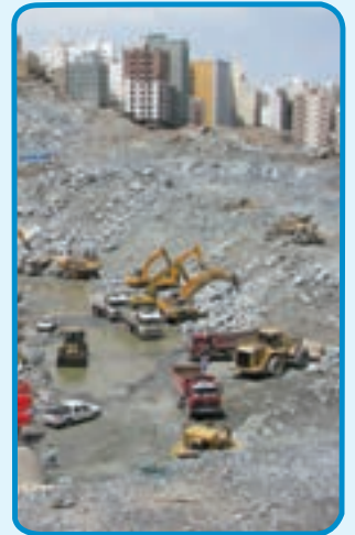
شکل ۳-۷- گودبرداری در زمین‌های نامحدود
