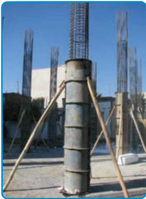
شکل ۳-۳۳- قالب فلزی برای ستون بتنی با مقطع دایره
