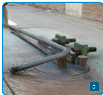
شکل ۶۴-۳- خم کردن میلگرد
