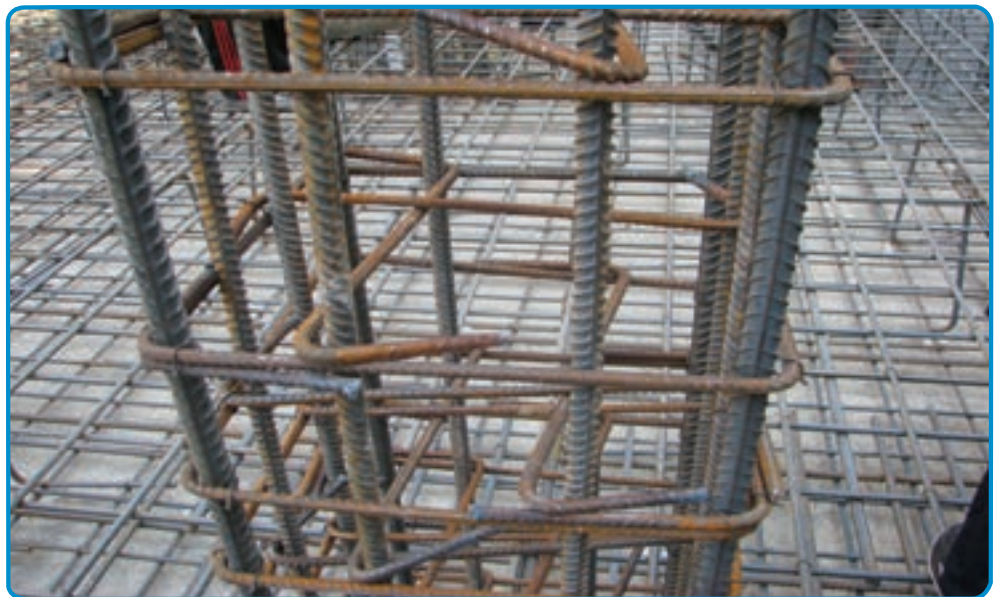
شکل ۳-۵۰- کاربرد سنجاقک در میلگرد گذاری ستون
