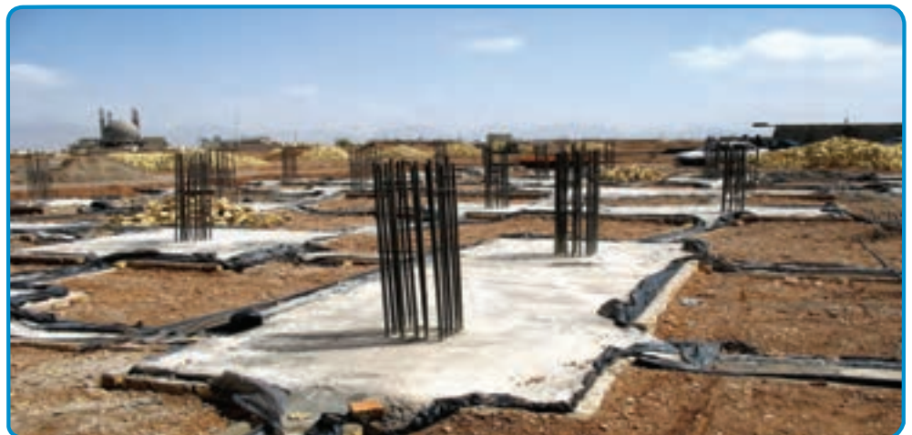
شکل ۱۰-۳- استفاده از پلاستیک در پی
