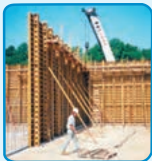
شکل ۱۹-۳- فایبر گلاس برای اجرای دیوار بتنی
