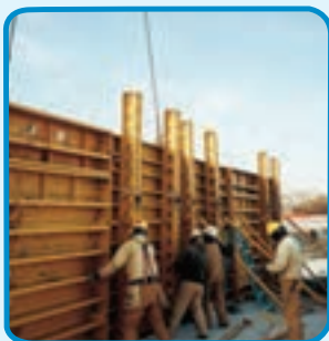
شکل ۳-۳۶- قالب فایبر گلاس برای اجرای دیوار بتنی
