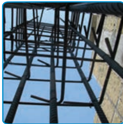
شکل ۱۹-۷- کار گذاشتن میلگردهای انتظار ستون، در فونداسیون
