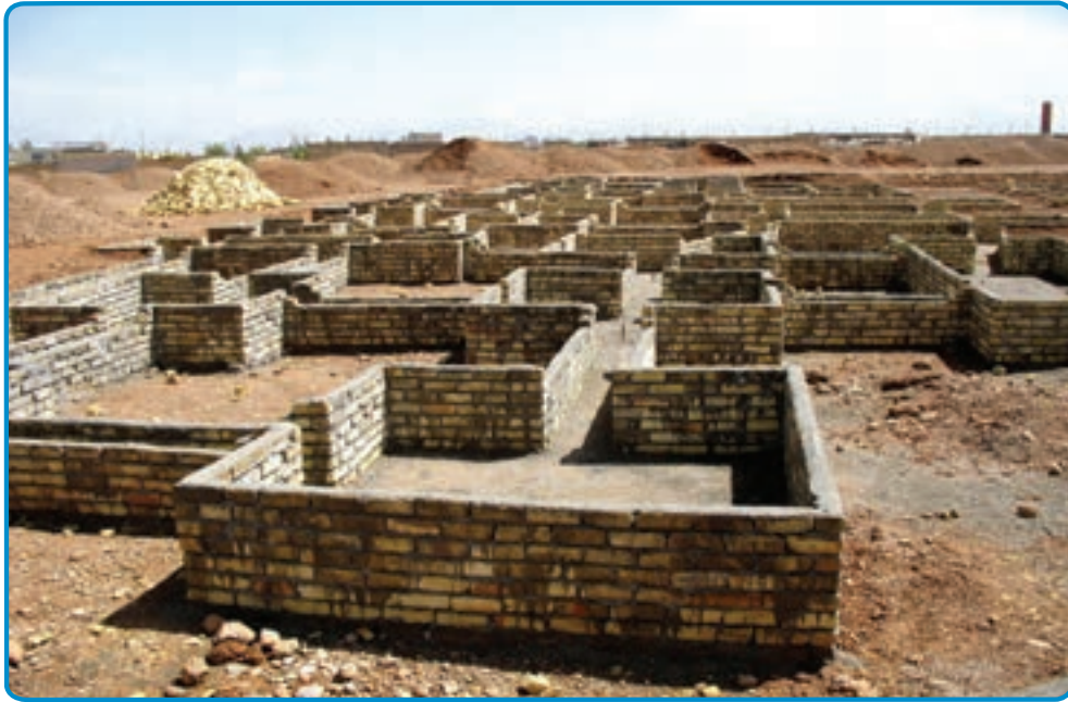
شکل ۱۵-۳- استفاده از قالب آجری برای اجرای پی
