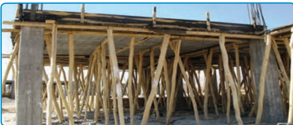
شکل ۲۴-۳- استفاده از شمع‌های چوبی جهت نگهداری قالب‌ها
