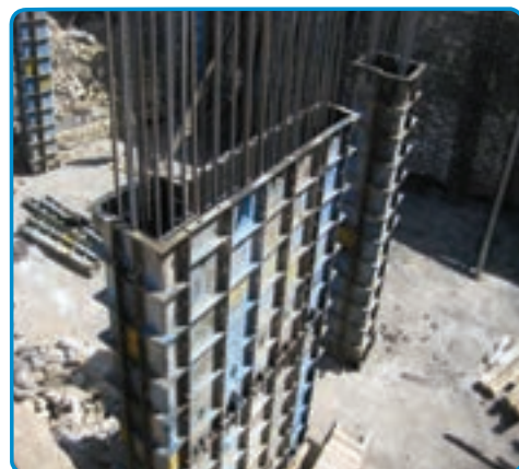
شکل ۳-۳۵- قالب فلزی برای اجرای دیوار بتنی
