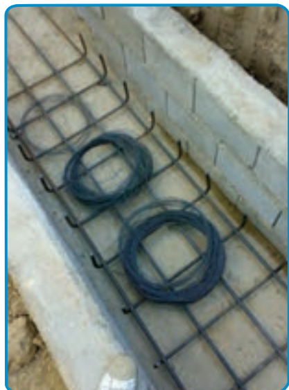
شکل ۹-۷- بهم بستن میلگردها
