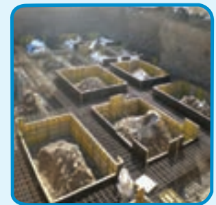
شکل ۳-۳۱- قالب فایبرگلاس برای اجرای پی
